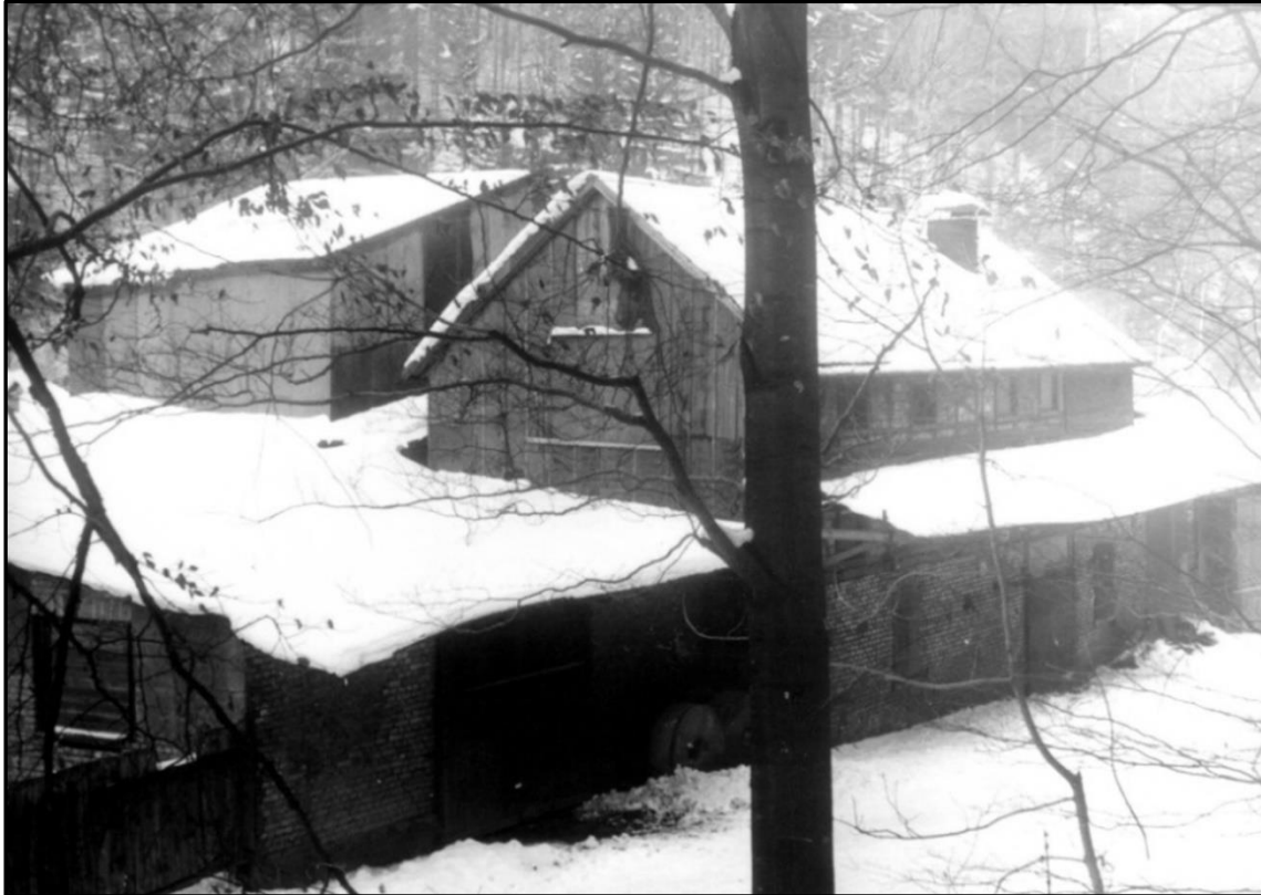
Abb. 14: Die Braunsteinmühle im Jahr 1989, Blick von SO, Foto: R. KRAUSE, Geraberg.
